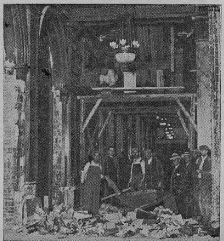
Como nuestros lectores saben, el famoso hotel Waldorf Astoria de Nueva York fué vendido, para ser construido en el sitio que ocupó un edificio que será el más alto del mundo, pues tendrá una elevación de mil pies y más de setenta pisos. Para instalar el hotel será a la vez construido un edificio en Park Avenue. Aquí vemos la demolición de las casas en el lugar que ocupará el nuevo hotel.
